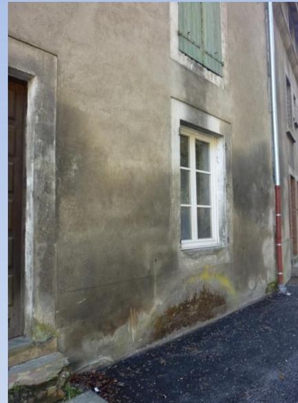
Sols imperméables amplifiant les remontées capillaires dégradant le mur
