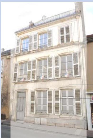
Enduit et modénature plâtre et chaux.
